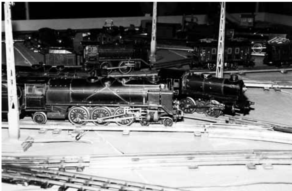
Eine Parade der Tin-Trains. Deutlich ist das elektrische Dreileitersystem der 32-mm-Spurweite von Märklin zu erkennen. Ca. 1927
